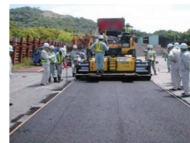
アスファルト合材の打設・転圧
