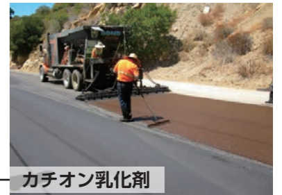
コールドミックス合材 (花王の乳化剤+水+アスファルト+骨材)
