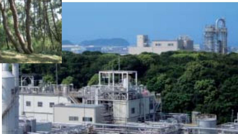
工場施設内の防潮林
