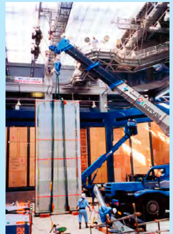
大水槽にアクリルガラスを設置する建設現場(沖縄美ら海水族館)
