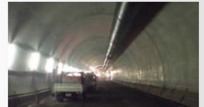
写真1 「マイテイ 3000V」を使用したトンネルの内面
