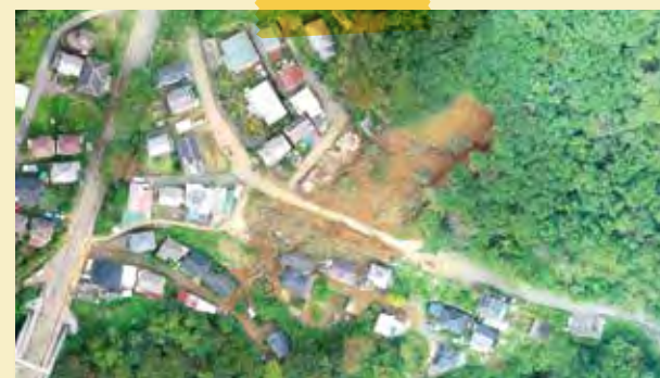
民家を巻き込む土砂災害（神奈川県相模原市）
