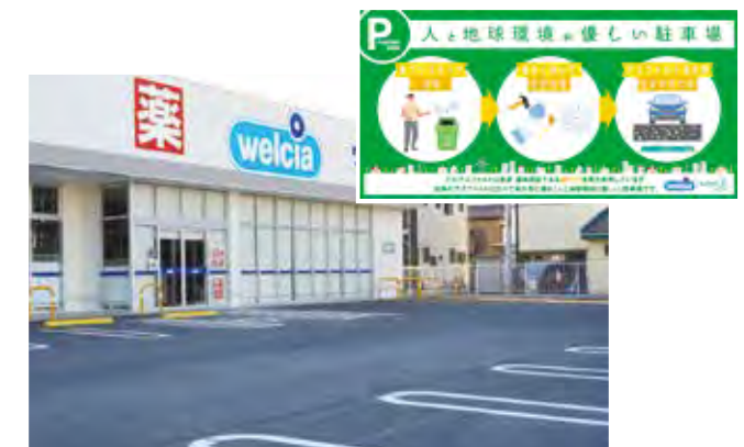
図6 ウエルシア 藤沢用田店の駐車場
